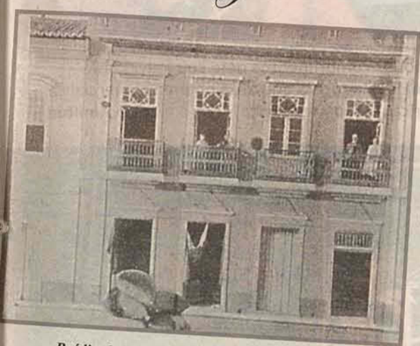
Prédio da rua Gustavo Richard, em 1911.
